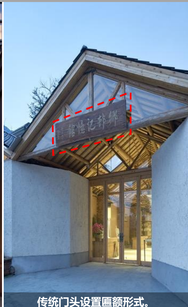
设于雨棚上方，支撑钢架喷漆与背景融合。
