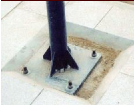
基础埋深不够，法兰应下埋；
