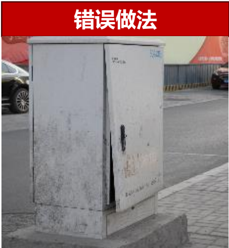
维护门破损;
